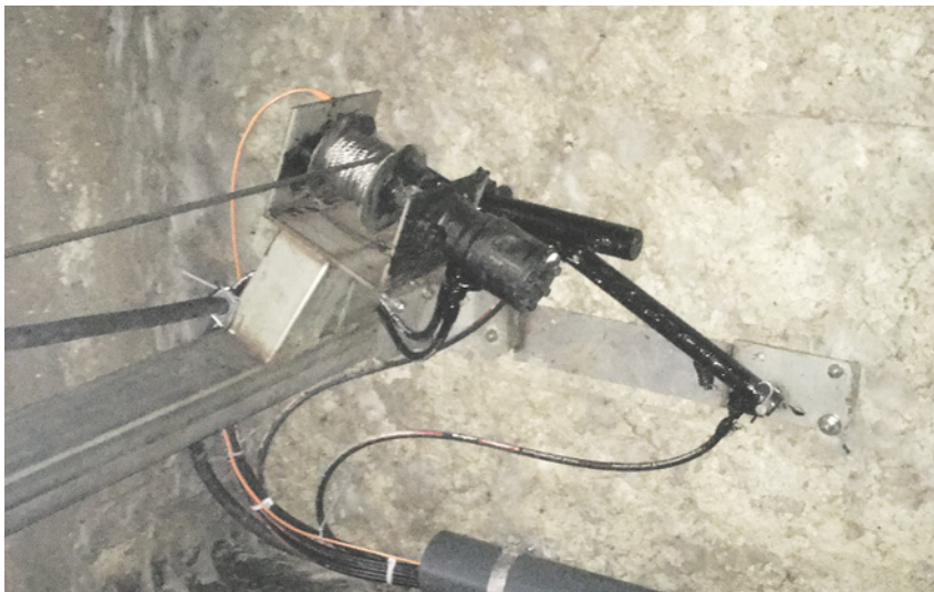
Das Reck des Tauchmotorrührwerks montierte Patrick Rudin vor der Mitteltrennwand. So ist eine optimale Gülleumwälzung möglich. Bild: Patrick Rudin
