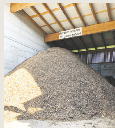
Holzschneitzelheizung sorgt für Wärme im Schweinestall. Bild: aem
